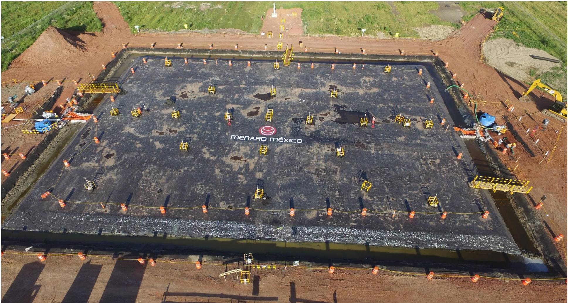
Figura A.4. "Panel de prueba de consolidación acelerada con vacío con membrana - Menard Vacuum - Vista aérea de la zona de prueba recubierta con la membrana impermeable y e la zanja de estanqueidad perimetral."
