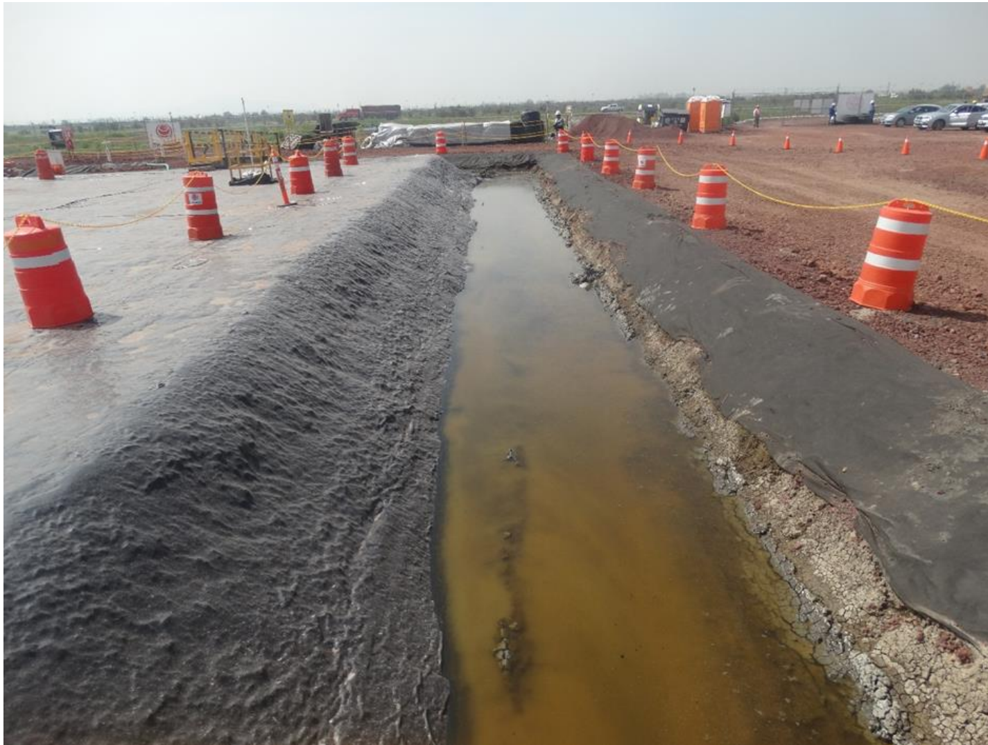
Figura A.3. "Panel de prueba de consolidación acelerada con vacío con membrana - Menard Vacuum - Vista de la zanja de estanqueidad perimetral."
