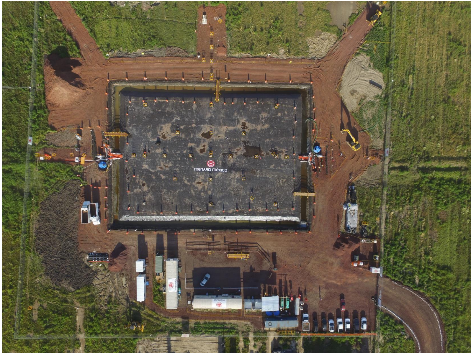
Figura 4. "Vista aérea de la zona del panel de prueba de consolidación acelerada con vacío con membrana - Menard Vacuum - La imagen fue tomada antes de la colocación del relleno de compensación final, por lo que es posible observar la membrana impermeable y la zanja de estanqueidad perimetral al panel de 50 x 70 m. El norte está a la izquierda de la foto."
