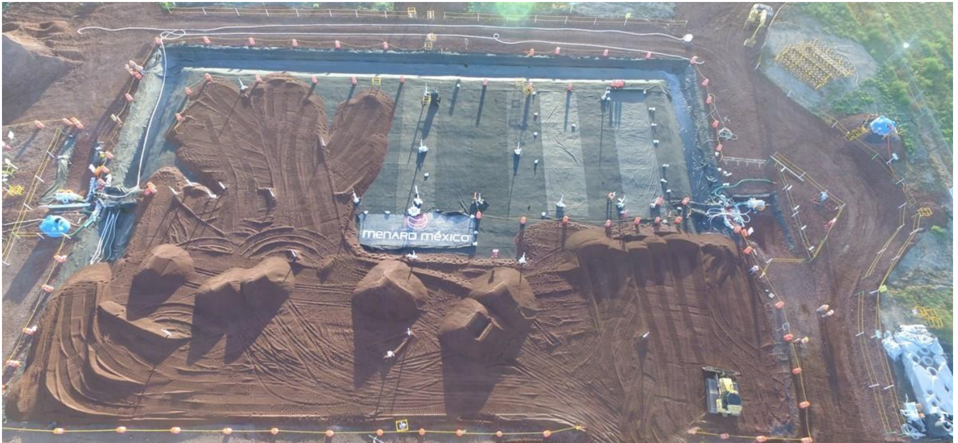
Figura A.5. "Panel de prueba de consolidación acelerada con vacío con membrana - Menard Vacuum - Vista aérea de la zona de prueba al momento de la instalación del relleno de compensación."
