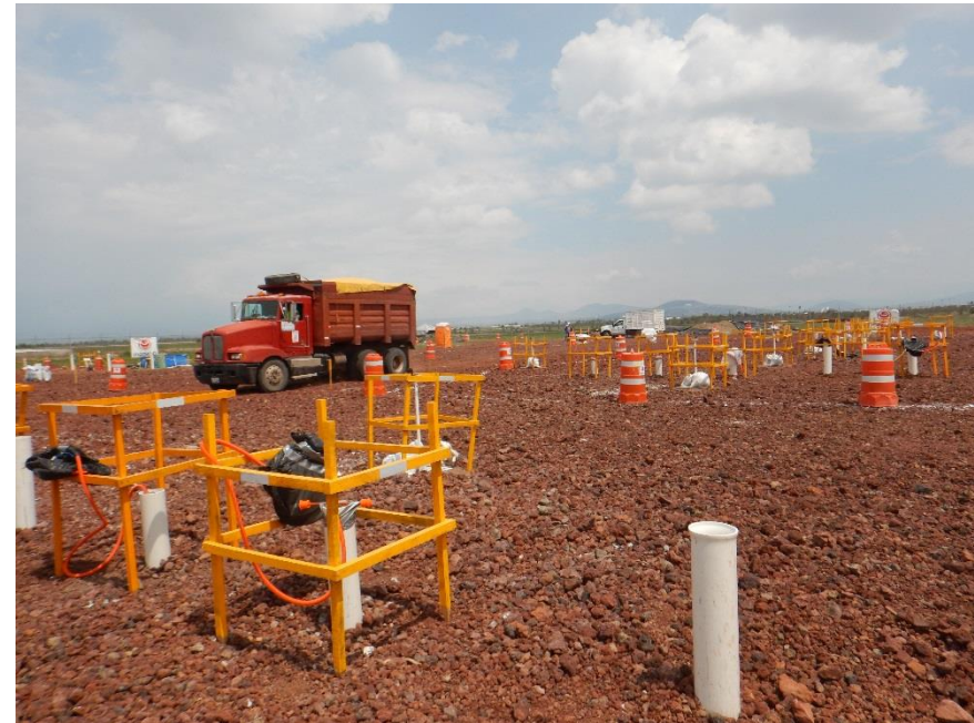
Figura A.1. "Panel de prueba de consolidación acelerada con vacío con membrana - Menard Vacuum - Conformación de plataforma de trabajo preliminar e instalación de instrumentación."
