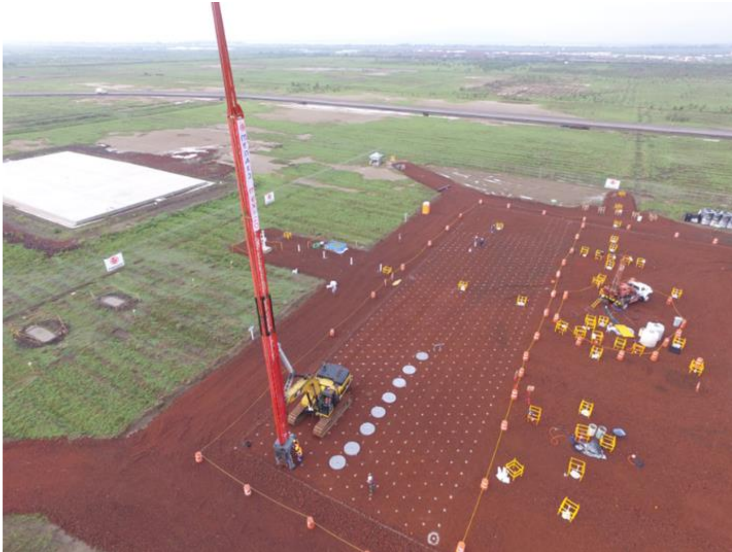
Figura A.2. "Panel de prueba de consolidación acelerada con vacío con membrana - Menard Vacuum - Instalación de Drenes Verticales Prefabricados."
