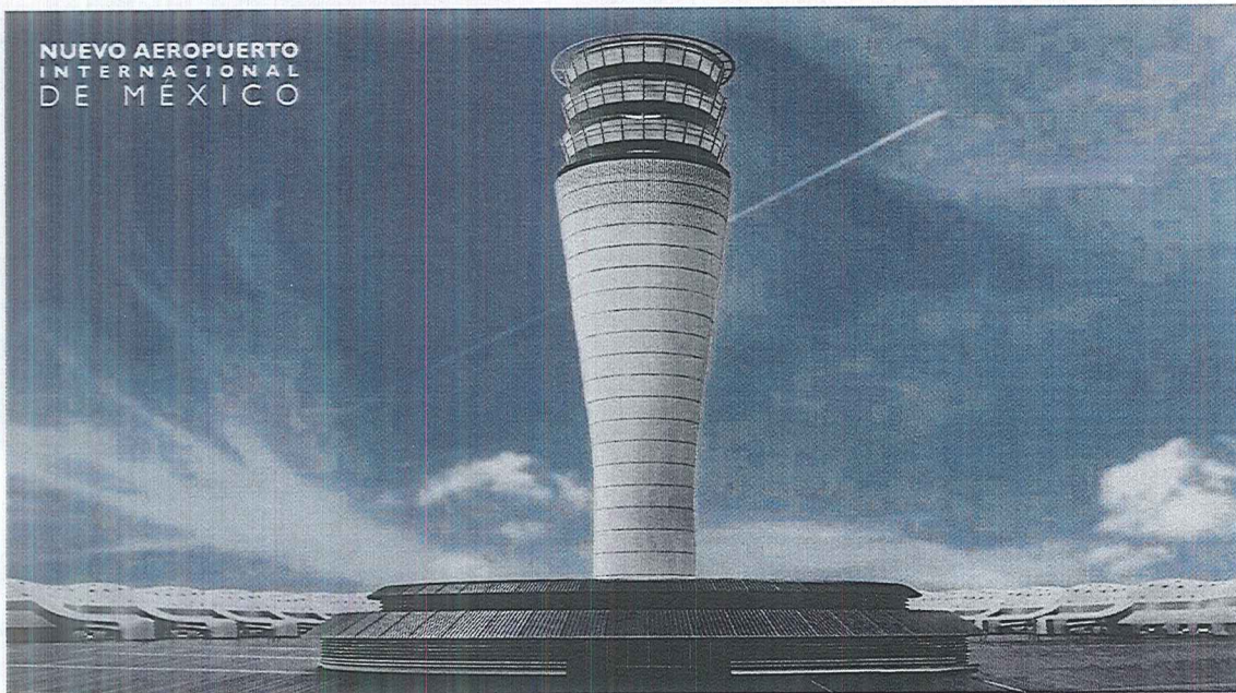
Figura 1.4.- Torre de Control de Tráfico Aéreo
