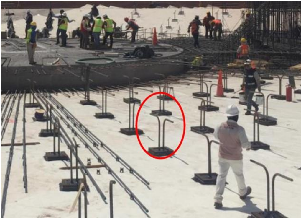
Figura 7. Varillas de anclaje de cada pilote a la losa de cimentación
