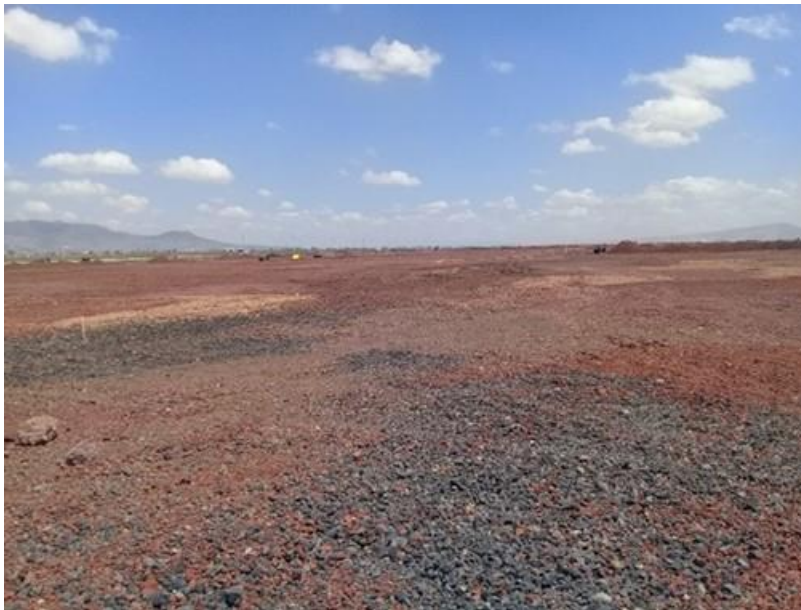
Fig. An.4.3.4.2 Primeras capas de tezontle.
