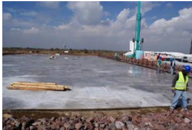
Figura 5. Colado de la losa inferior, 12 de noviembre 2014
