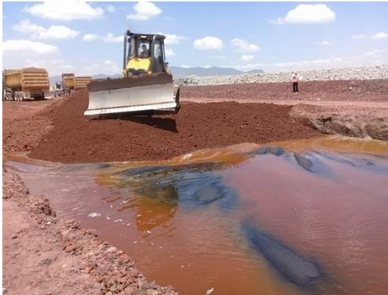
Fig. An.4.3.4.1 Instalación del tezontle sobre geotextil.
