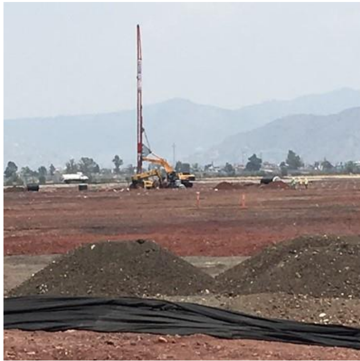
Fig. An.4.3.3.3 Instalación de drenes verticales.
