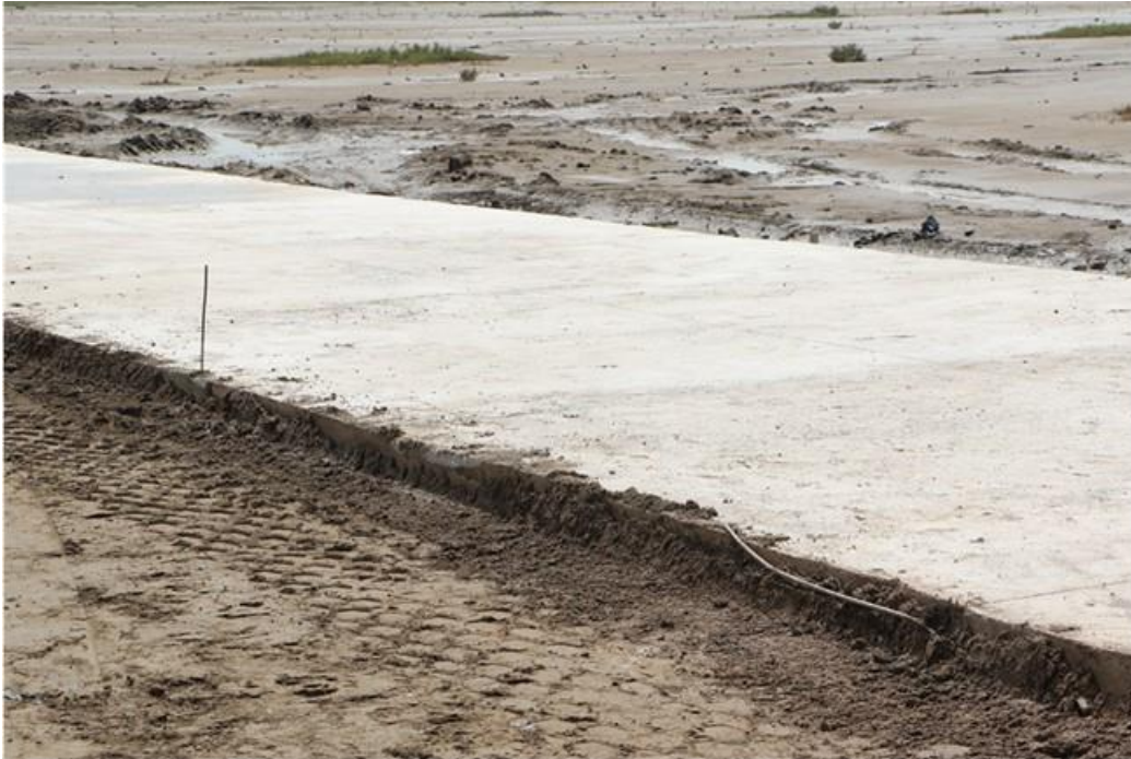
Figura 4.9.2.3. Construcción de la plataforma con inclusiones en Septiembre de 2015
