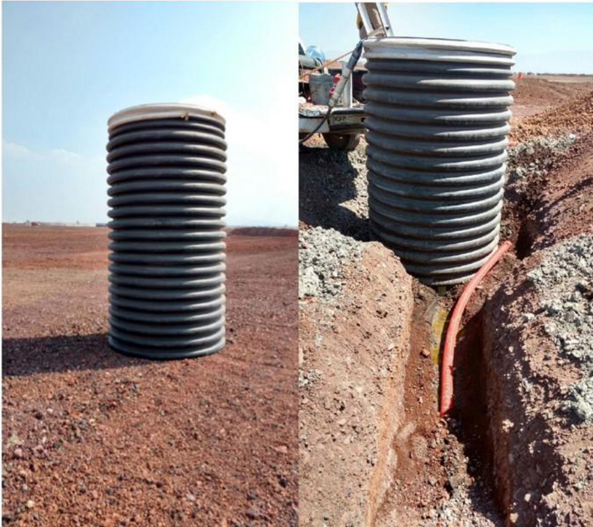
Figura 1. Tubo PEAD para registro de los tramos de manguera, para definir el perfil de asentamientos
