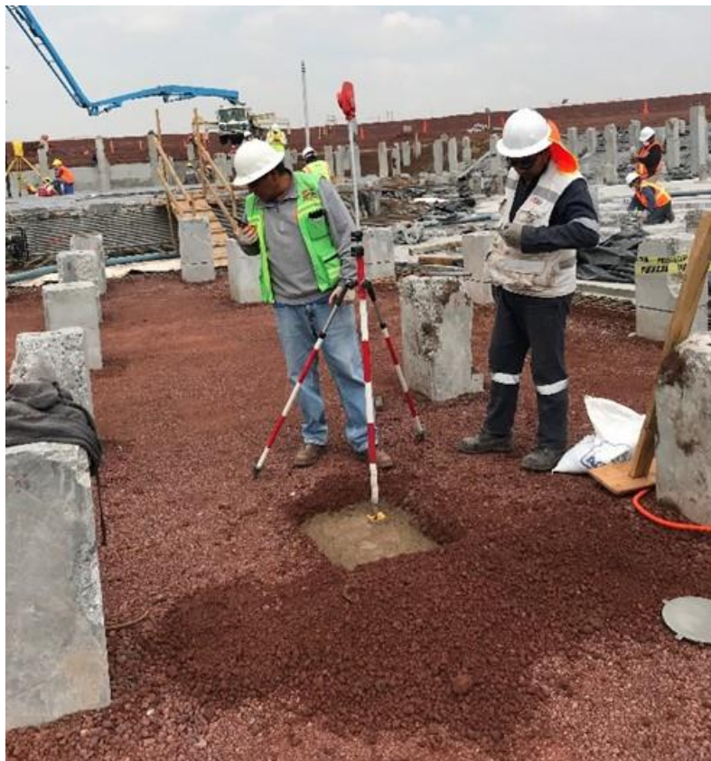
Fig. 4.4.7.6 Medición topográfica de la ubicación de una celda de presión.
