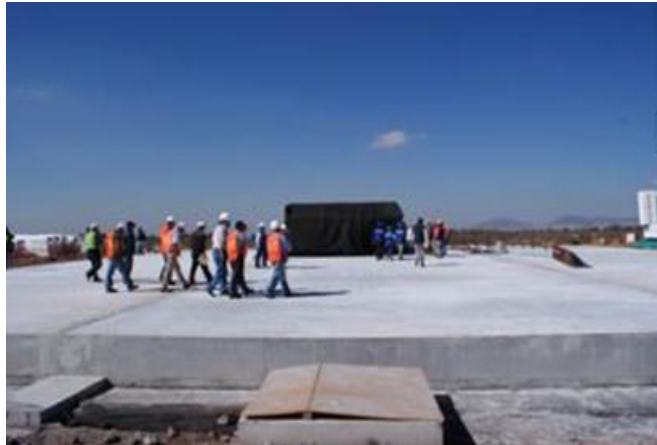
Figura 8. Plataforma A terminada, 9 de diciembre 2014
