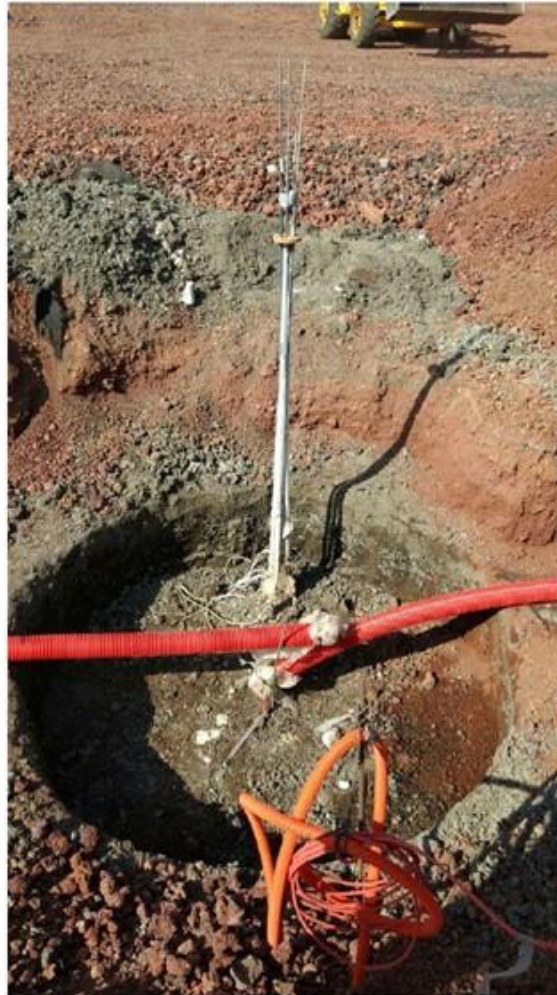
Figura 3. Cabeza de extensómetro y mangueras para definir el perfil de asentamientos, en el sitio de un futuro registro
