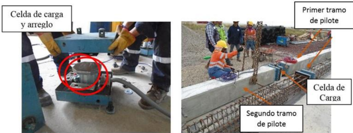
Figura B2. Celdas entre tramos de pilote
