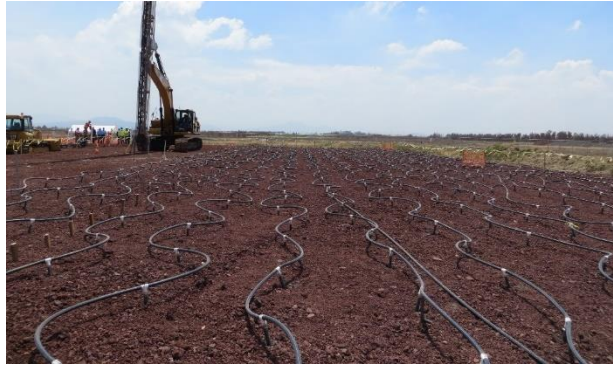
(b) Sistema de tubería horizontal flexible
