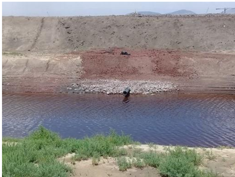
Fig. An.4.3.4.4 Dren horizontal seco.
