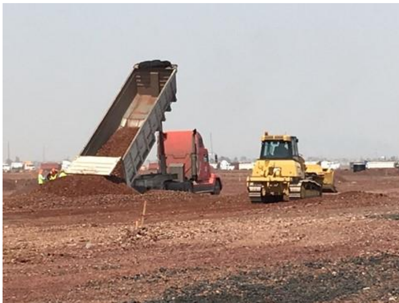
Fig. An.4.3.3.2 Colocación de tezontle.
