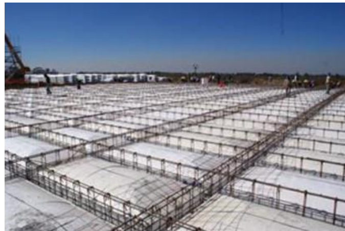
Figura 6. Colocación de los aligerantes y del acero de refuerzo, 26 de noviembre 2014
