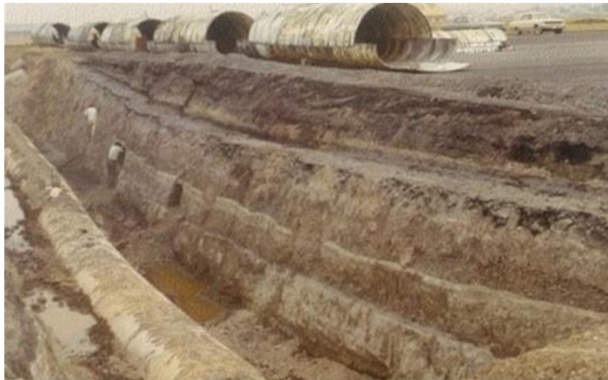
Fig. 4.1.4.1 Capas sucesivas indentadas en el suelo (AICM).
