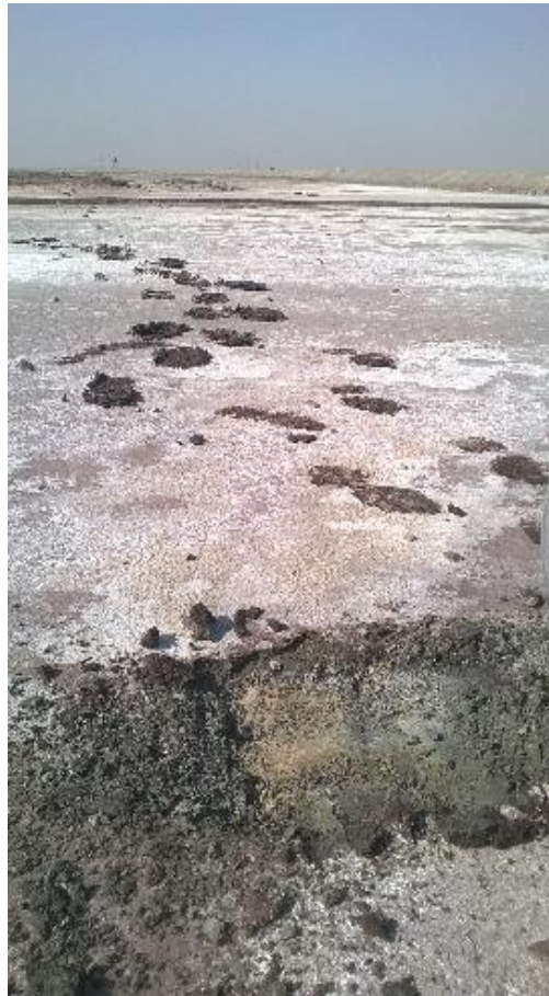
Figura 4.9.2.7. Vista del material de azolve sobre la plataforma
