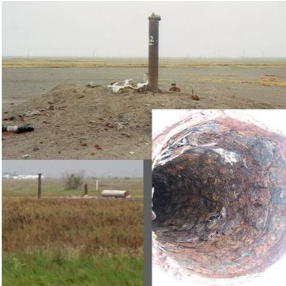
Figura 4. Emersión de un ademe de pozo en la zona sur del predio del NAICM.
