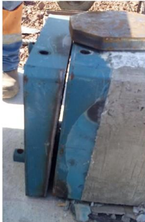
Figura B5. Instalación de placa que implementó el constructor para ajustar la verticalidad del tramo
