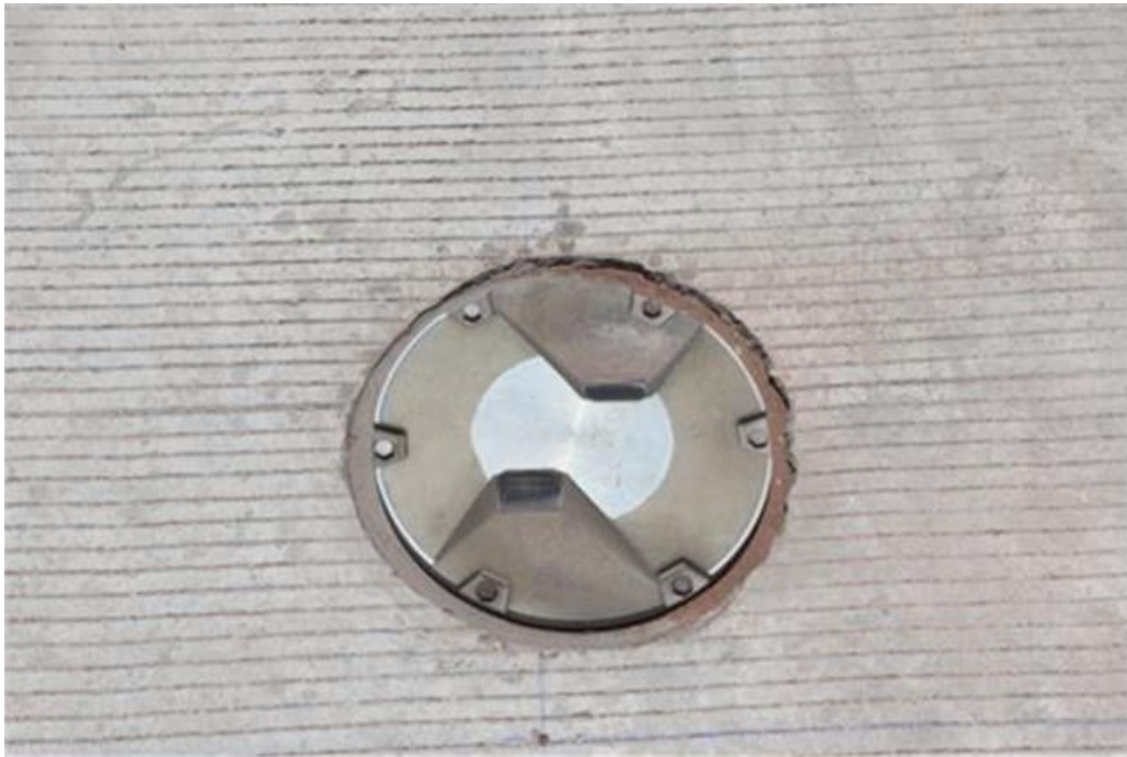
Figura 57. Grietas Plataforma B
