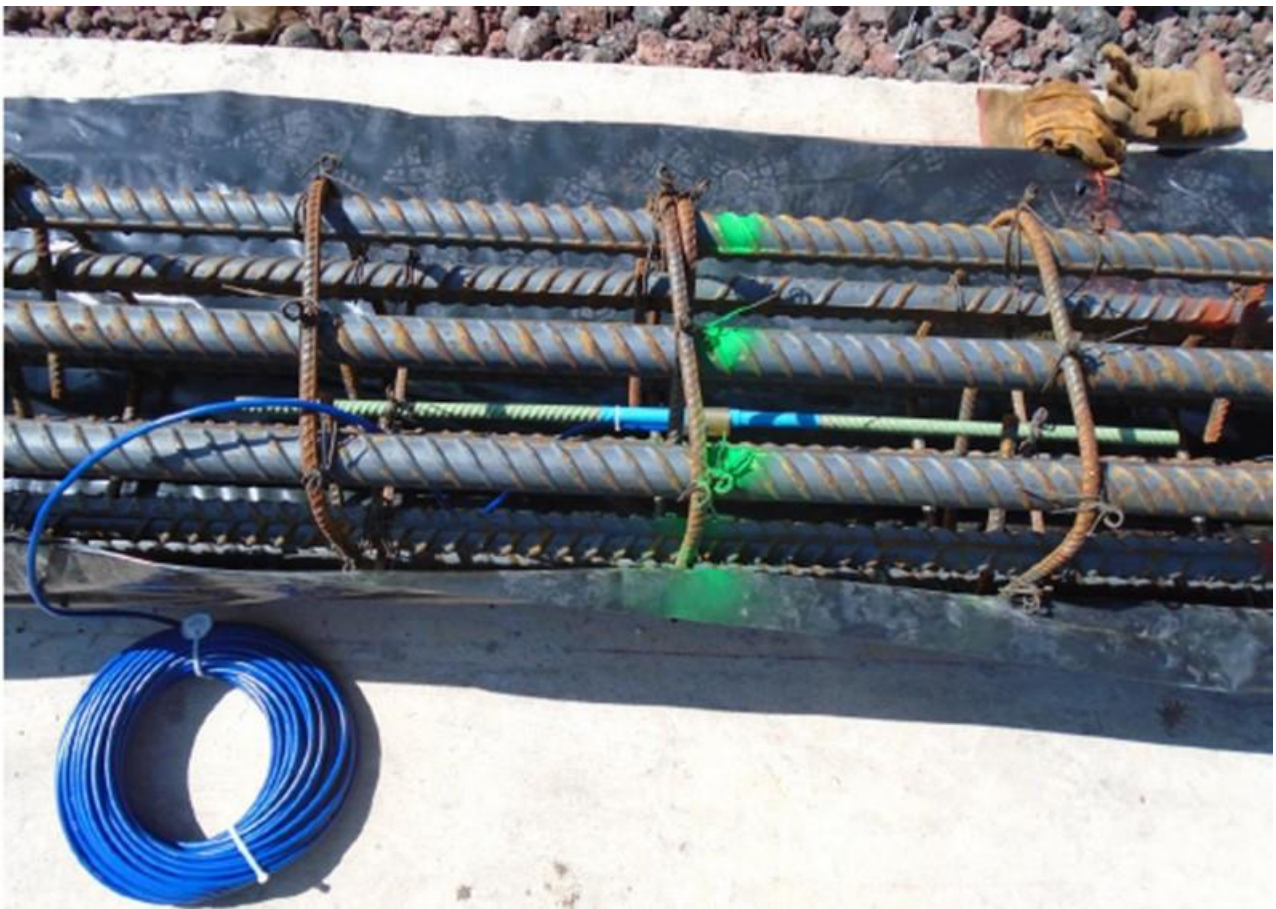
Figura B1. Varilla instrumentada instalada en el armado de un segmento del pilote 4, el cual fue hincado en la zona del Edificio Terminal
