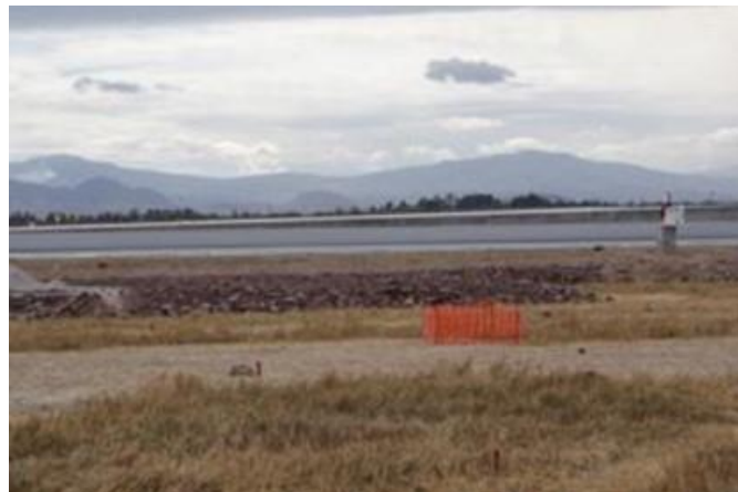
Figura 9. Plataforma B terminada, 3 de febrero 2015
