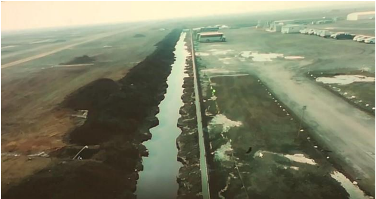
Figura 3. Vista hacia el sur de zanja exterior llena, a un costado de la cerca, para captar el flujo proveniente del “reservorio de agua” (CFE).
