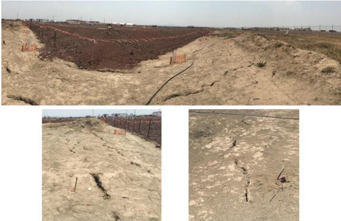
Figura 22. Grietas ocasionadas por la presión de vacío en el contorno del terraplén de prueba
