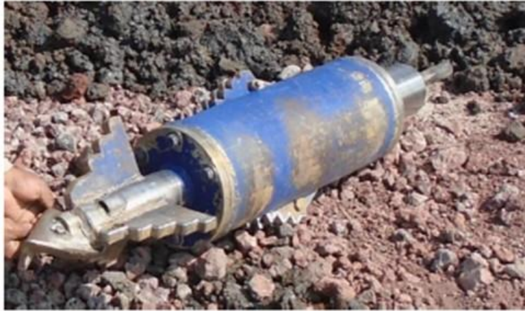
Figura B7. Broca empleada en la pre-perforación del pilote 4
