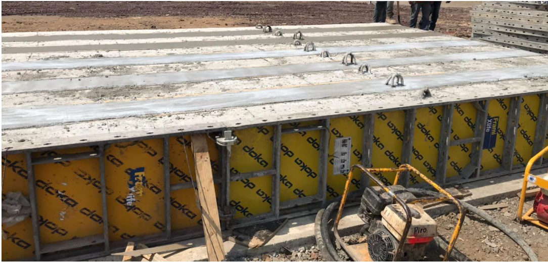
Fig. 4.9.2.2. Colado de pilotes con cimbra metálica
