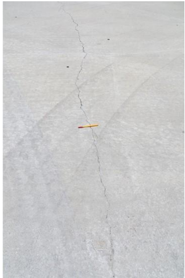
Figura 67. Agrietamientos asociados a procesos de colado de las losas
