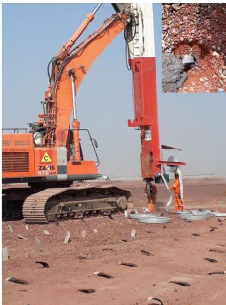
Instalación de drenes verticales
