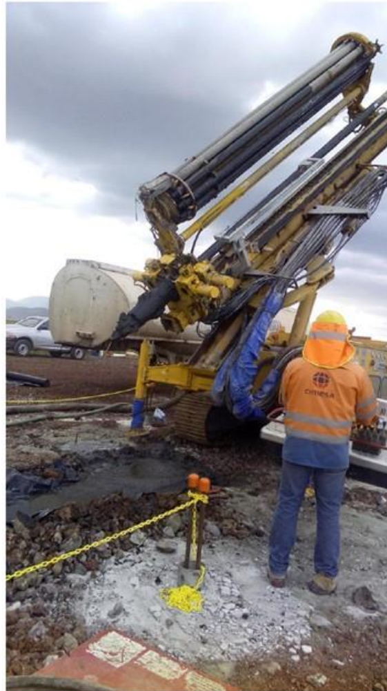
Figura B6. Equipo empleado en los trabajos de pre-perforación del pilote 4
