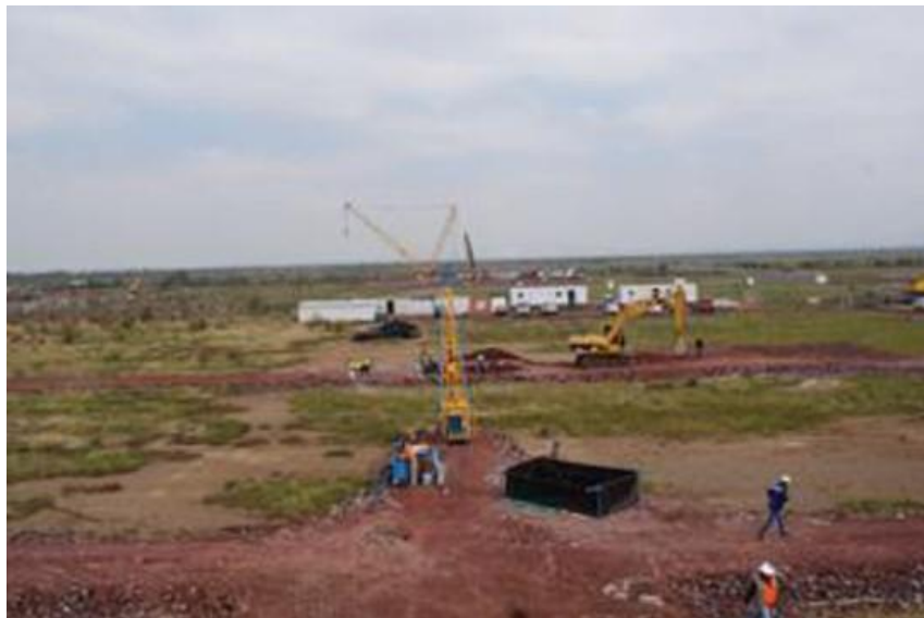
Figura 3. Exploración geotécnica, 15 octubre 2014.
