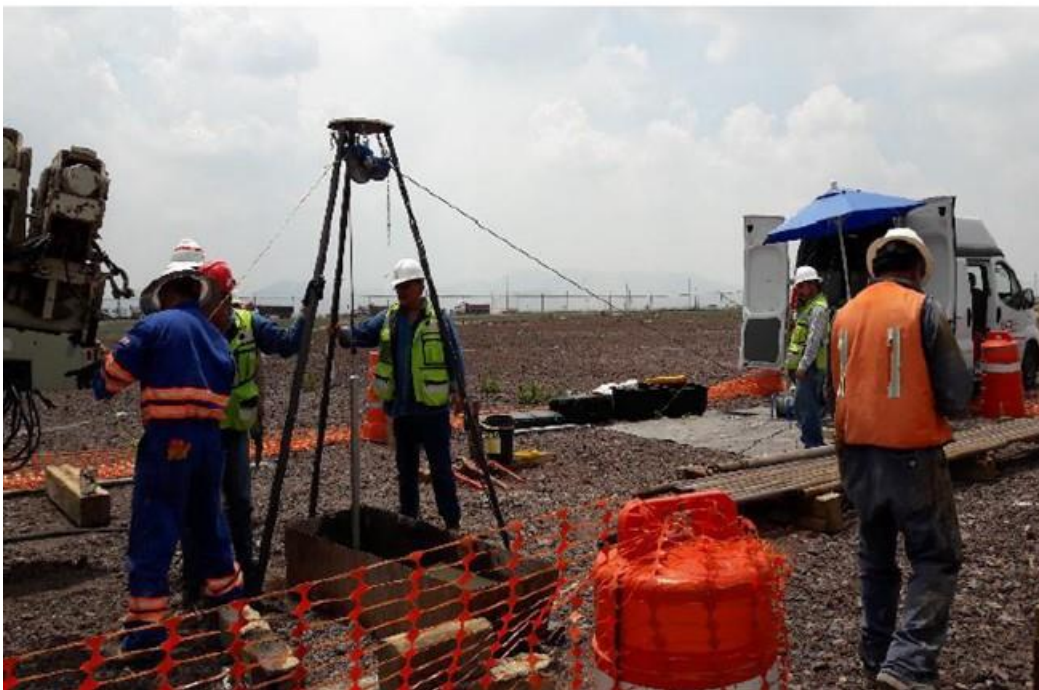
Figura 1. Ensayo de sonda suspendida en el tramo de vacío dren a dren.
