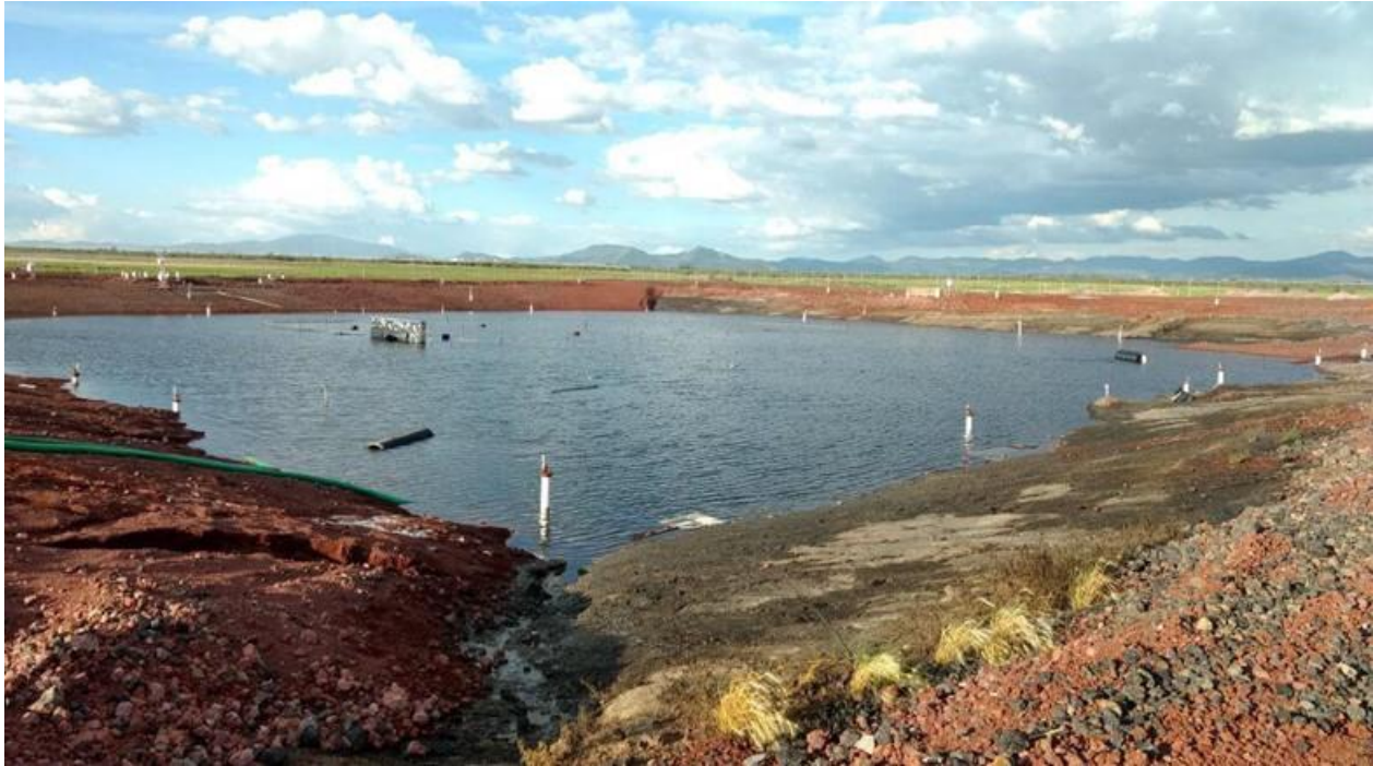
Fig. 2 Estado actual de la excavación de prueba.
