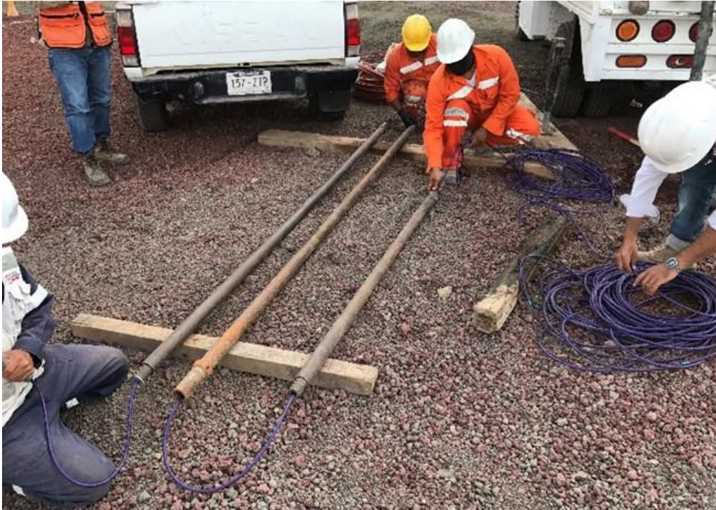
Fig. 4.4.7.2 Introducción del cable del piezómetro en la tubería.
