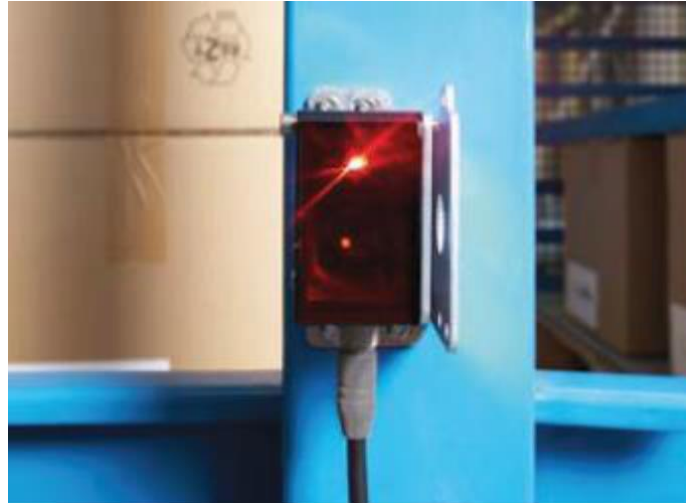
Figura 10. Distanciómetro fijado y en operación.
