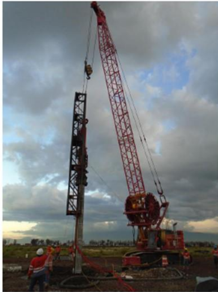
Figura B8. Hincado del pilote 4
