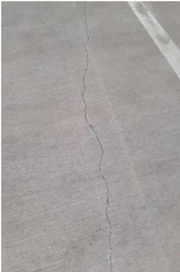
Figura 67. Agrietamientos asociados a procesos de colado de las losas
