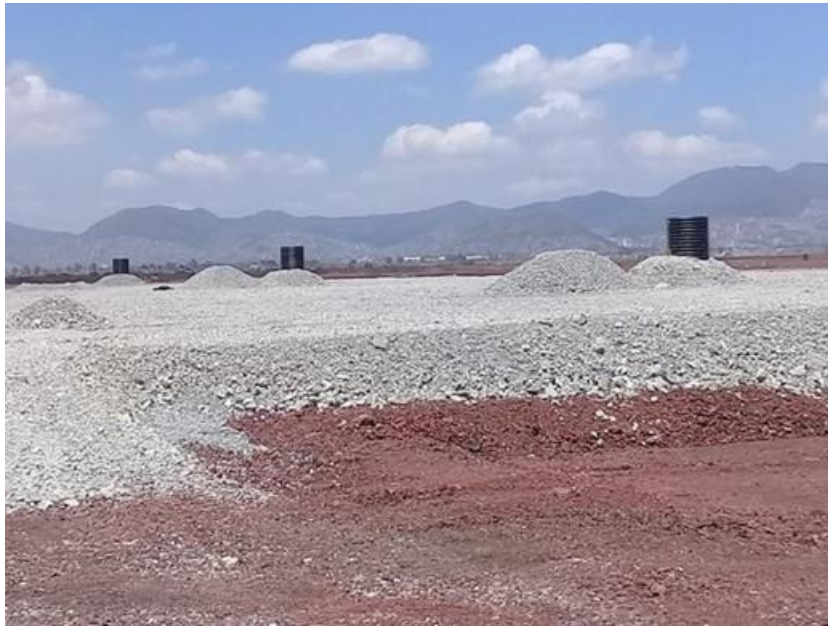
Fig. An.4.3.4.3 Material para sobrecarga instalado sobre el tezontle.
