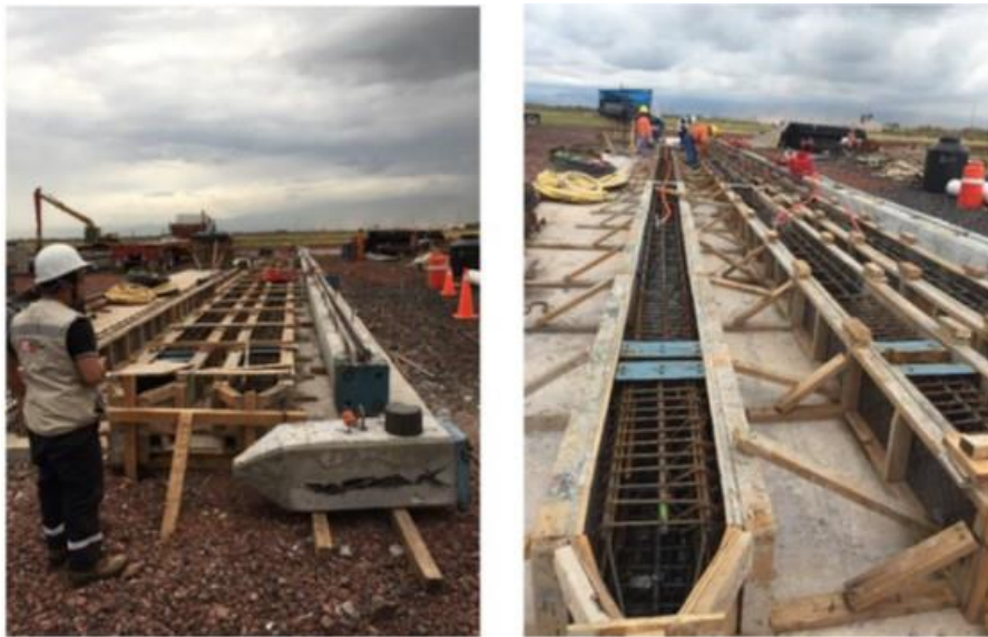
Fig. 4.2.2.2. Colado de pilotes instrumentados.
