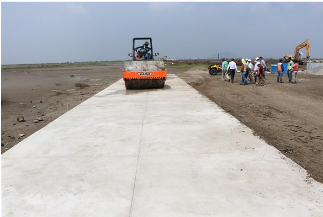
Figura 4.9.2.2. Construcción de la plataforma con inclusiones en Septiembre de 2015
