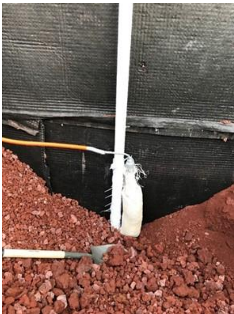
Fig. 4.4.7.12 Instalación de celdas de presión total
