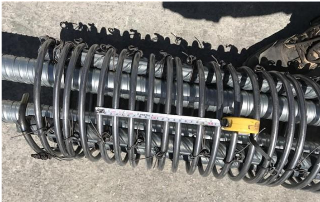
Figura 8. Tubos embebidos en el pilote para recibir las varillas de anclaje
