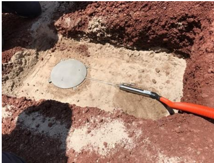
Fig. 4.4.7.5 Instalación de una celda de presión.
