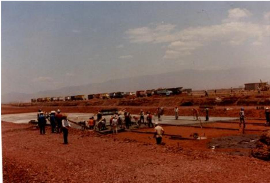
Figura 5.i.1.7 Colado de la losa de concreto (Zarate, 2014).
