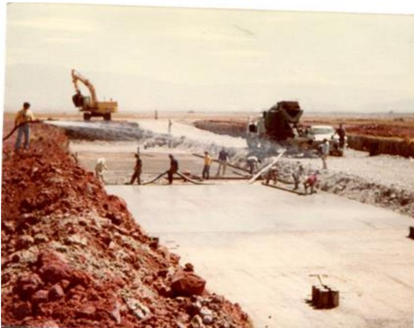
Figura 5.i.1.8 Otra vista del colado de la losa de concreto. A la derecha una franja de grava construida (Zarate, 2014).
