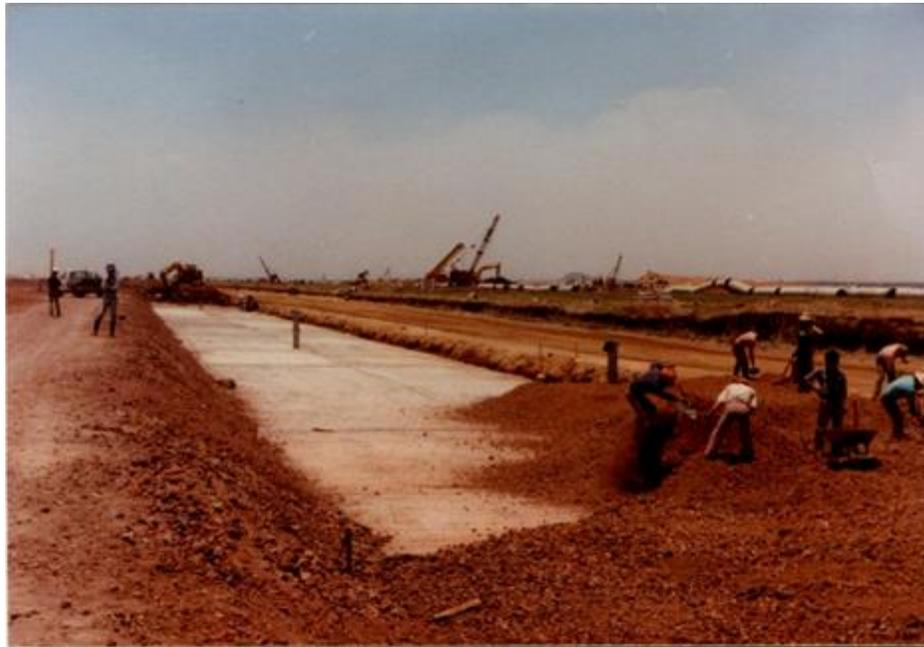
Figura 5.i.1.6 Colocación de la losa de concreto y el Tezontle, al fondo tubería para drenaje (Zarate, 2014).
