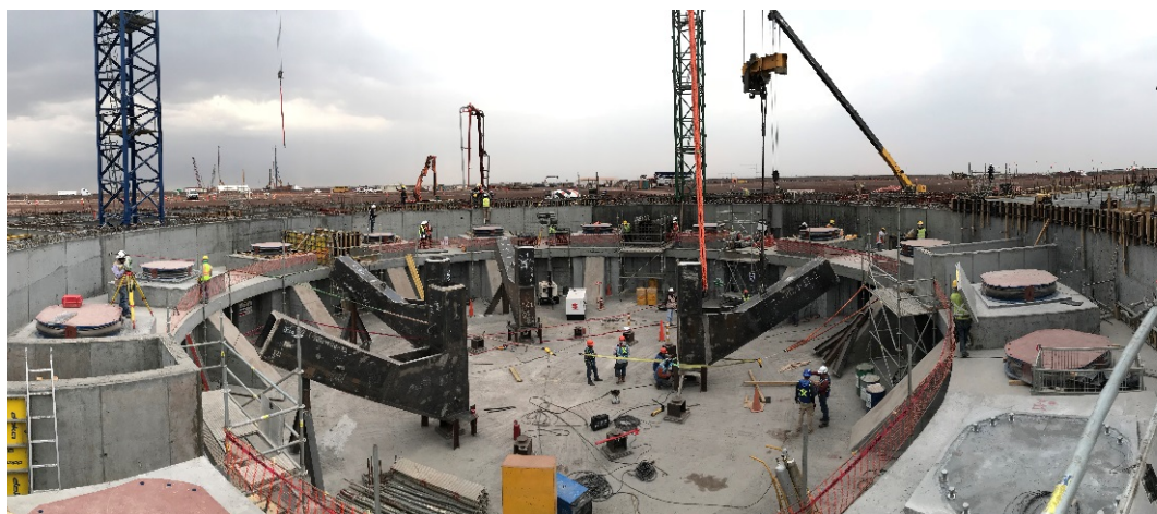
Aisladores de base instalados
