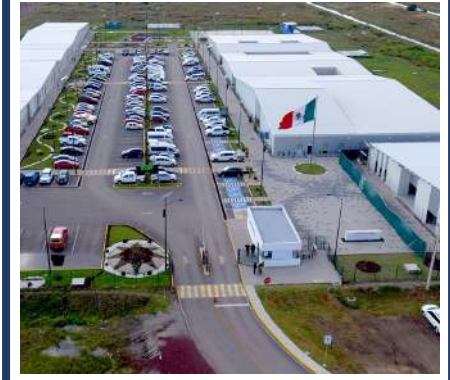
Campamento de obra
