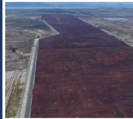
NIVELACIÓN Y LIMPIEZA DE LA PISTA 6
