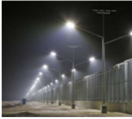
33 km de barda y camino perimetral
