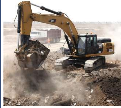
Remoción de 3.1 Mm 3 de escombros
