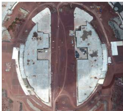
LOSA DE CIMENTACIÓN DEL CENTRO DE TRANSPORTE TERRESTRE
