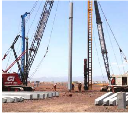
PILOTES DE CIMENTACIÓN
