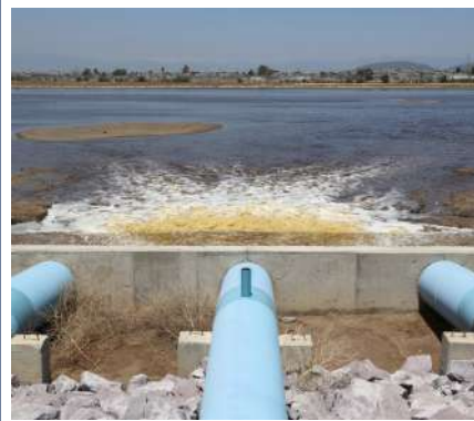
Drenaje para la construcción
