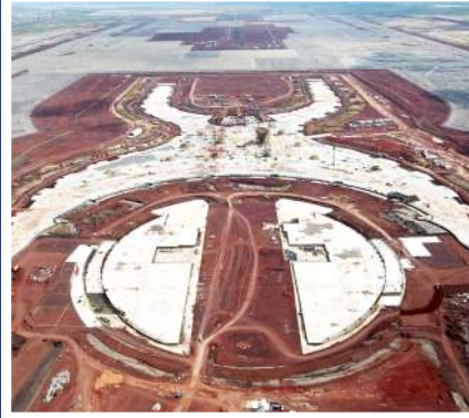
LOSA DE CIMENTACIÓN DEL EDIFICIO TERMINAL
