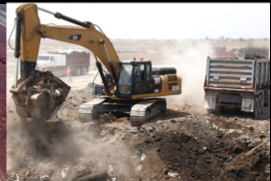
Remoción de Escombros
