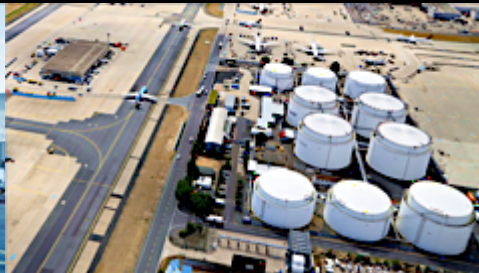
Terminal y Red de Distribución de Combustible
