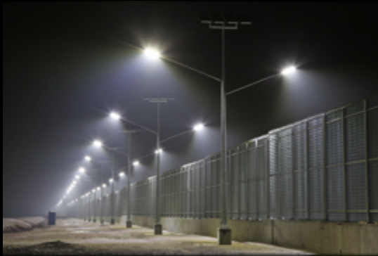
33 Km Barda y Camino Perimetral
