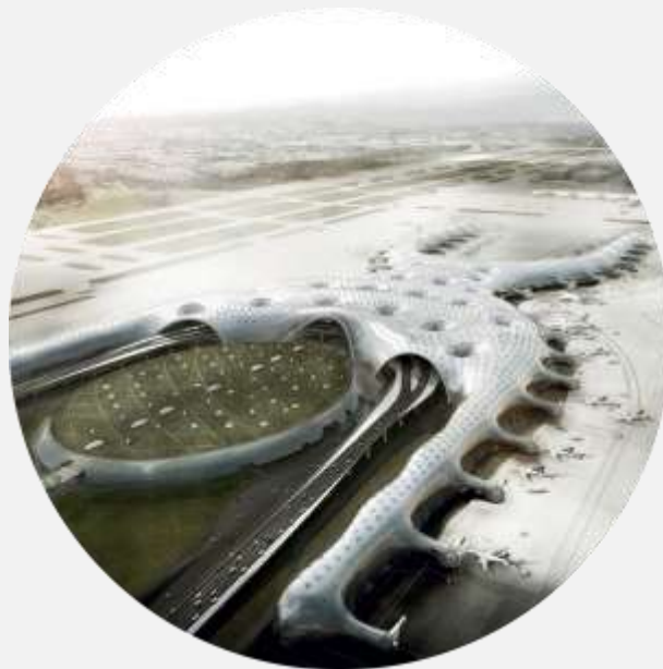
Nuevo Aeropuerto Internacional de la Ciudad de México (NAICM)
