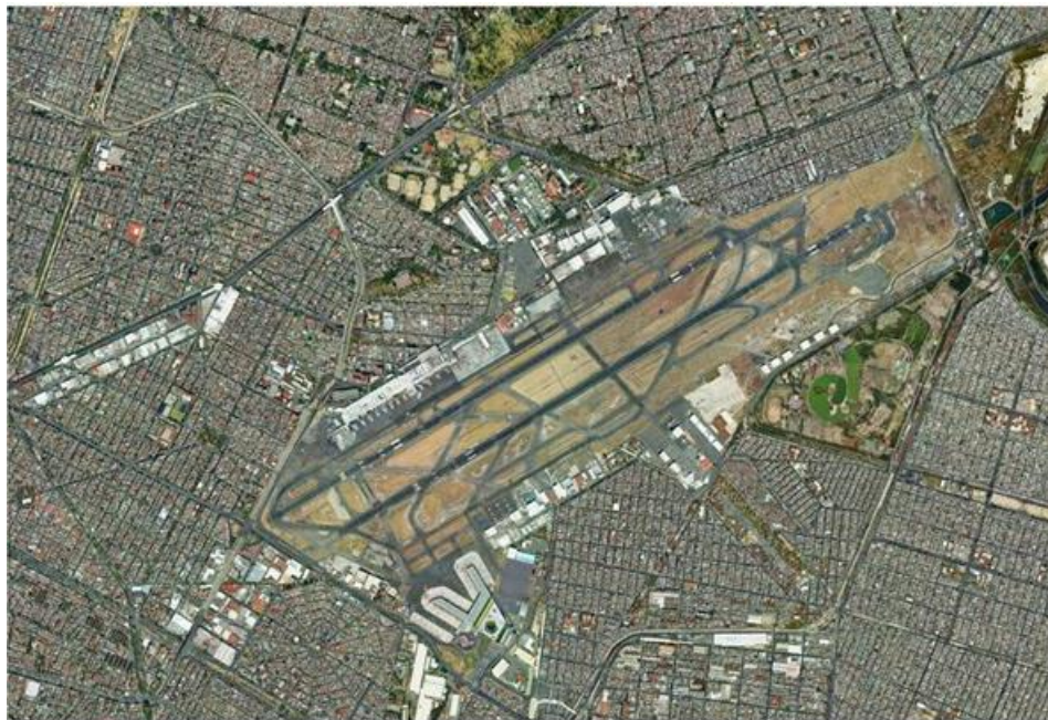
Fig. 13 Vista aérea del AICM
